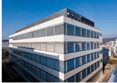
Roche Neubau Analytiklabor, Kaiseraugst
